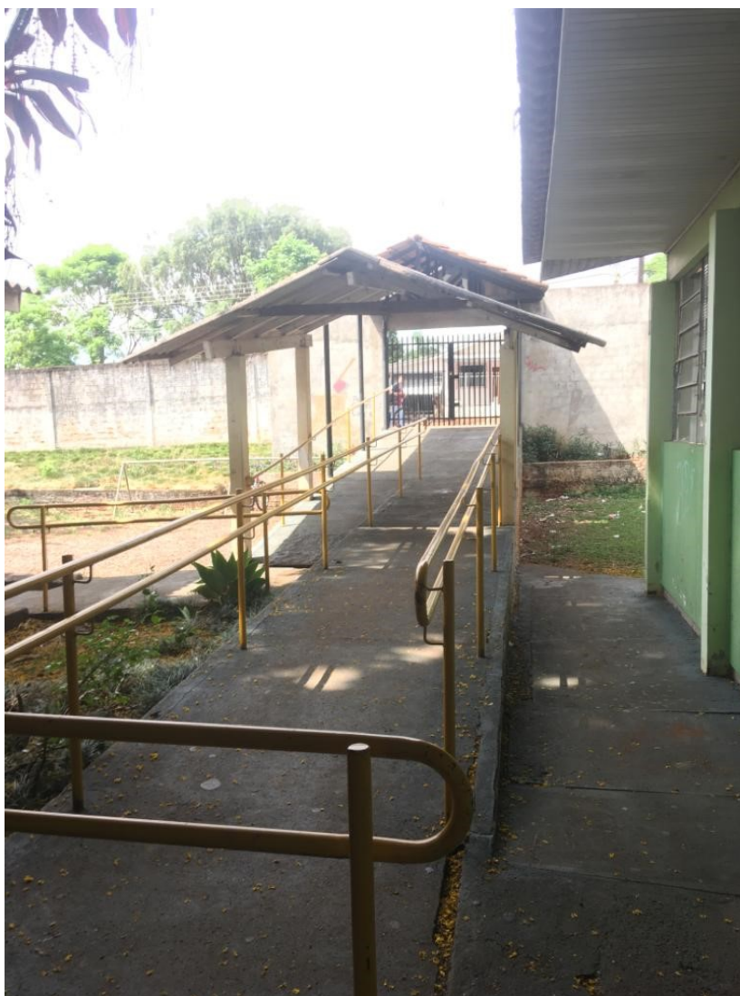
Figura 1: Rampa de Acesso
